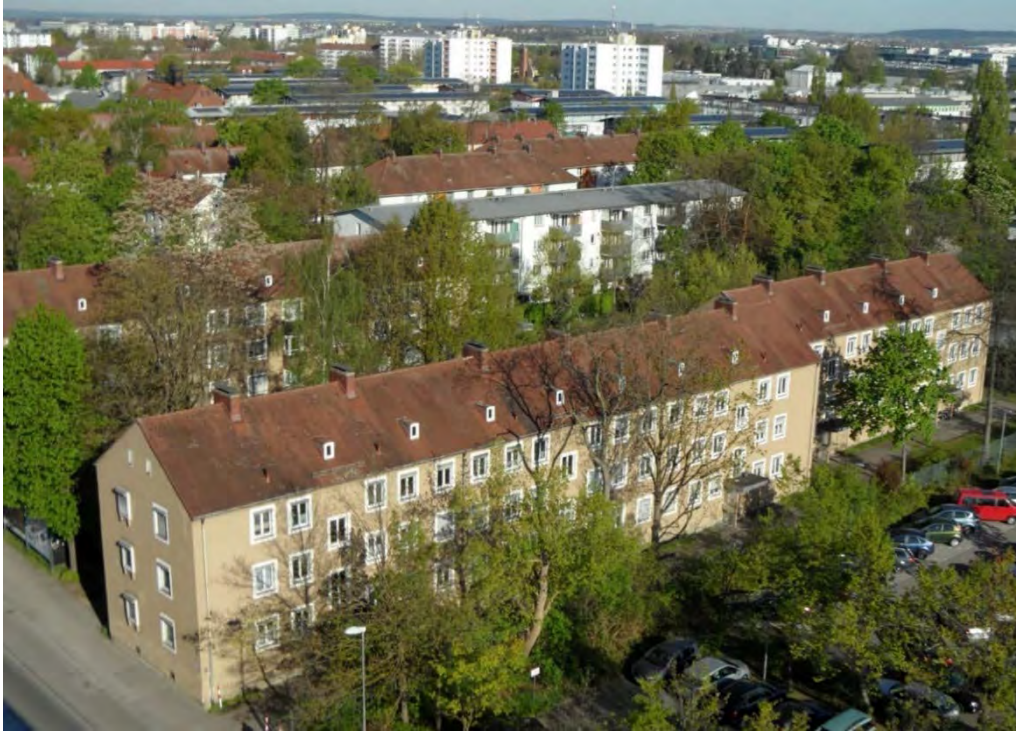
Abbildung 3-3: Aufnahme des Viertels Richtung Nordwest mit älteren Gebäuden (Ziegeldach) und neueren Gebäuden (Blechfalzdach)
