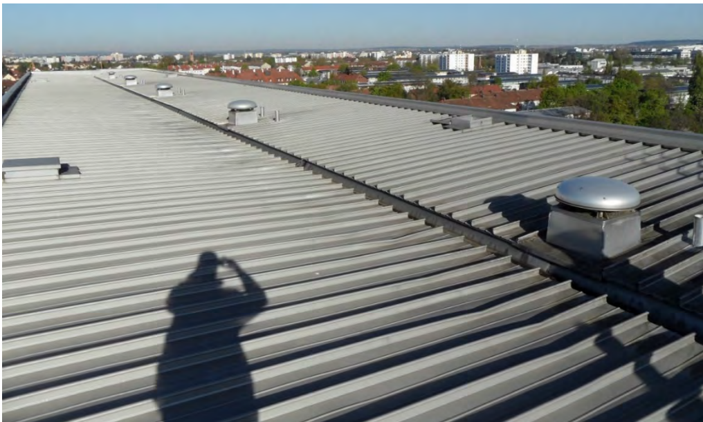
Abbildung 3-4: Blechfalzdach der Hindenburgstraße 57 (Westseite)
