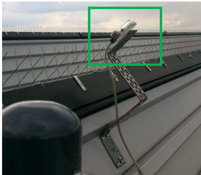
Abbildung 3-34: CS10 Einstrahlungssensor
