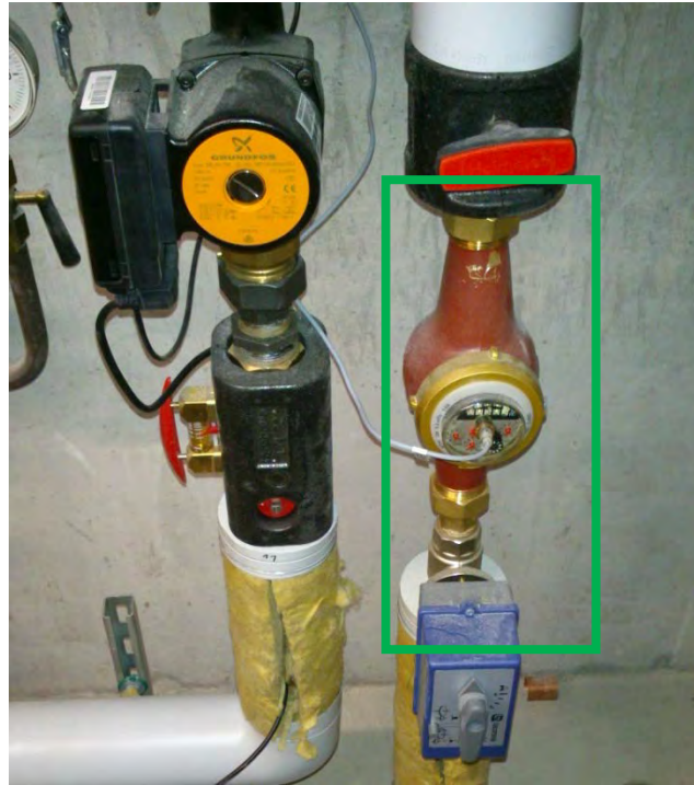
Abbildung 3-36: Volumenmessteil V40
